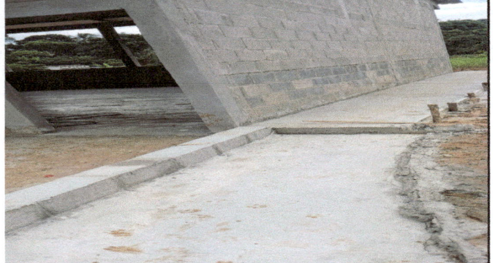
Foto 2: mejoramiento de la pared y el pasillo para que los estudiantes se desenvuelvan de una mejor manera en el ambiente escolar.
