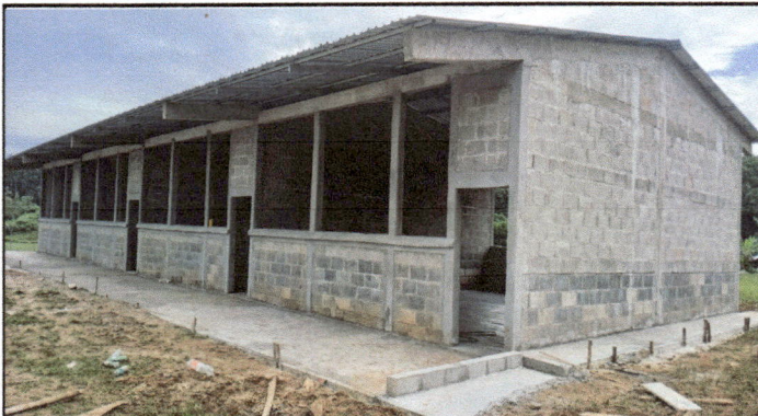
Foto 3: Mejoramiento de las paredes de las 4 aulas para que los estudiantes tengan un ambiente adecuado para recibir sus clases diarias.
