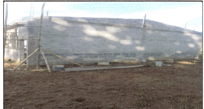
Foto 4: Se cambio toda las paredes de las 4 aulas con el apoyo de remozamiento y con la mano de obra de los padres de familia.
